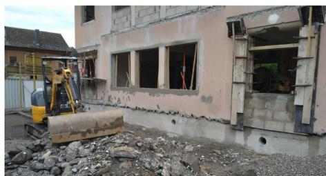
Les travaux se déroulent sans incident et respectent le planning. Le désamiantage du sol du 1er étage est fini depuis fin avril. Les démolitions des modénatures et des nouvelles ouvertures sont presque terminées. En principe le chantier devrait être terminé en fin d'année.
